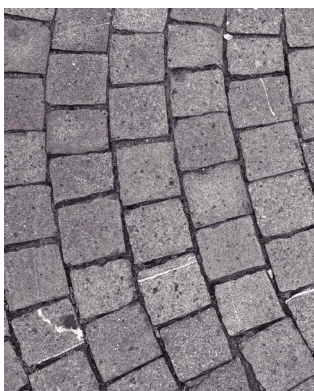
Pavage en arc, pose non liée
