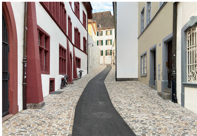
Asphalte et pavage : un compromis pour réaliser des chemins praticables dans la vieille ville de Bâle.
