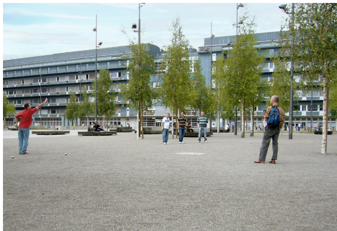
Un revêtement lié à l'eau comme à la Turbinenplatz de Zurich est praticable avec un moyen auxiliaire, si la couche de base est solide et le soupoudrage de grains fins est en mince.
