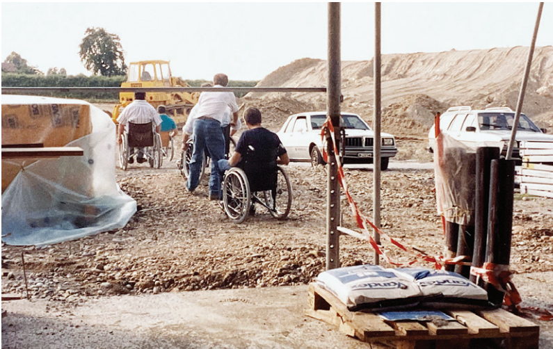
Commission « Personnes en fauteuil roulant » du Centre suisse, sur le chantier du Centre pour paraplégiques à Nottwil en 1988.
