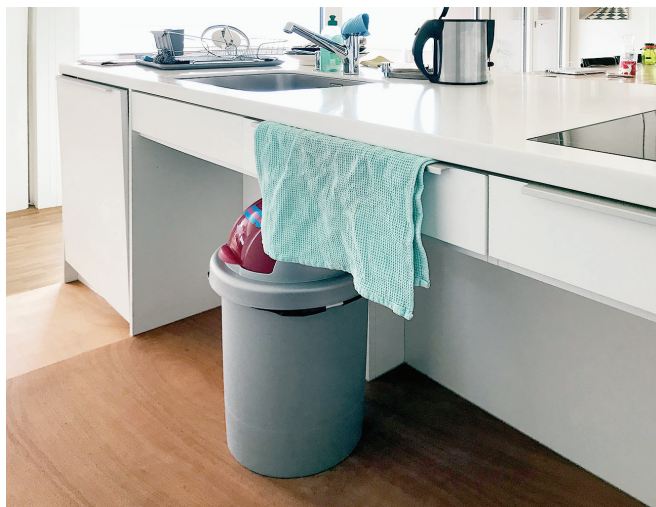
Les éléments en dessous des plaques de cuisson et de l'évier ont été enlevés et le sol surélevé grâce à une plateforme.
