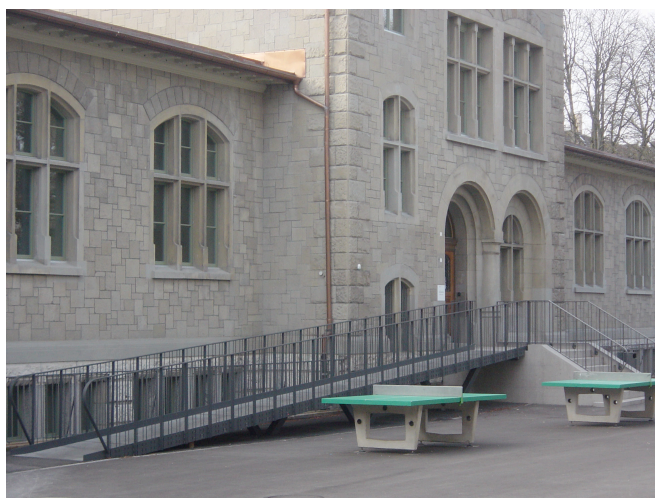
La rampe permet d'accéder à la Kernschule par la porte principale
