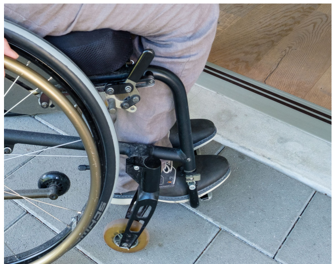
Logements et adaptabilité: mise en place de portes-fenêtres avec des seuils prévus pour les fauteuils roulants
