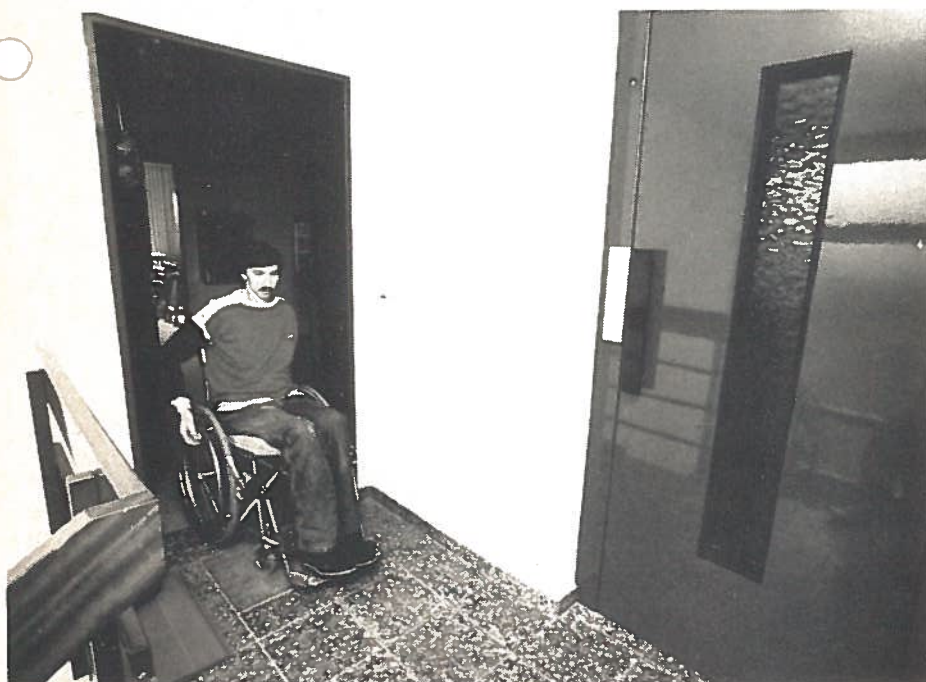
Exigence No. 1 dans la construction d'habitation. Une réalisation verticale sans marche.
