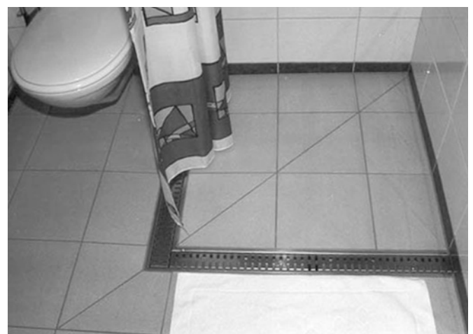
Douche avec gouttières plates en acier sur les côtés libres.
