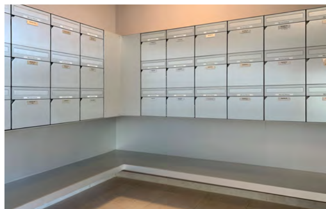
Système de boîtes aux lettres avec tablette: la rangée inférieure est facilement accessible depuis un fauteuil roulant
