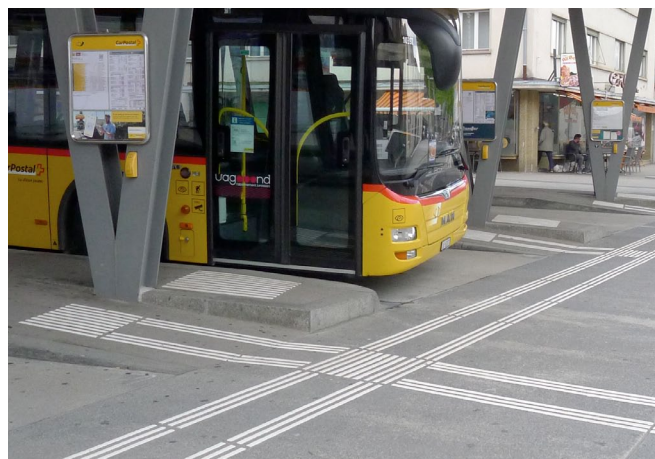
À la gare routière de Delémont, des lignes de guidage bien conçues amènent les voyageurs aux différents perrons.
